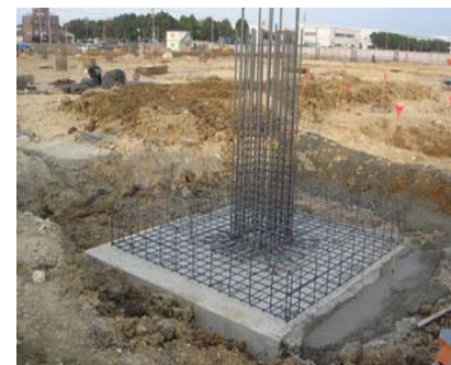
基礎工事状況
