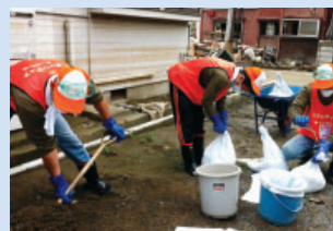
泥出しの様子
