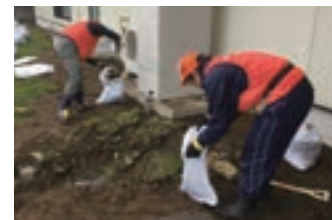
汚れた表土を除去
